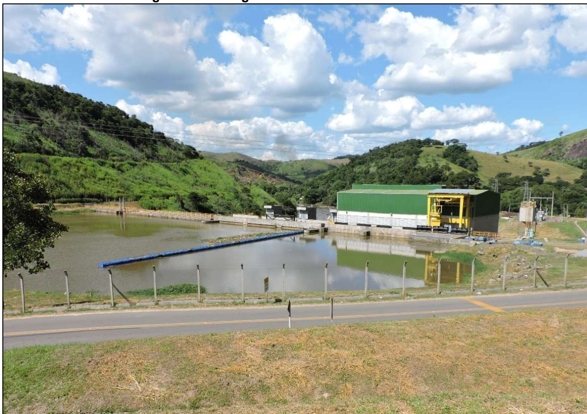
Figura 2 – Vista geral a montante da PCH Monte Serrat
