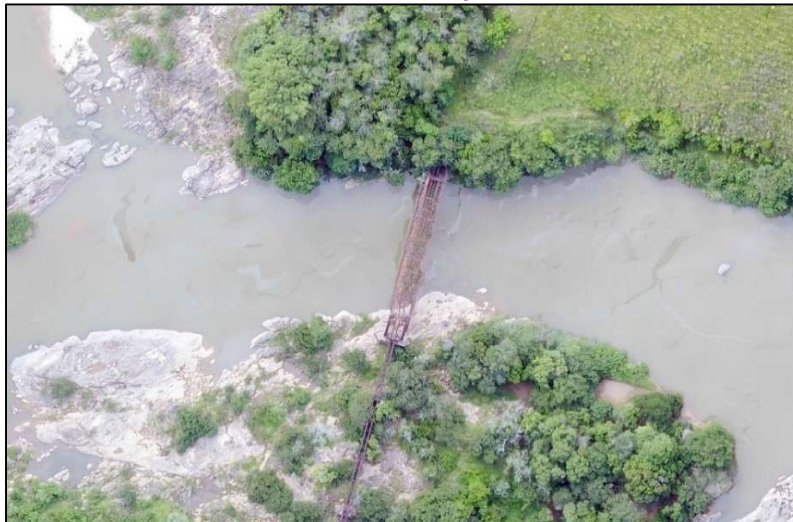
Figura 40 – Ponte 06 localizada entre os municípios de Chiador – MG e Três Rios - RJ
