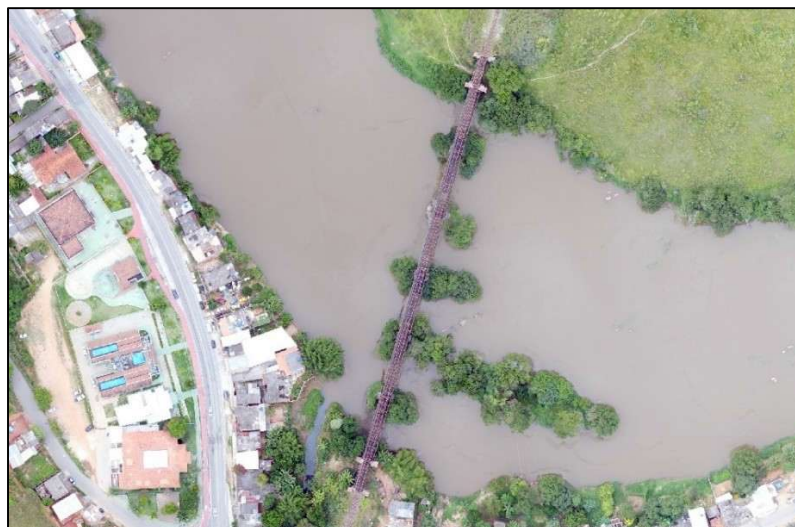
Figura 36 – Ponte 05 localizada entre os municípios de Comendador Levy Gasparian – RJ e Santana do Deserto – MG
