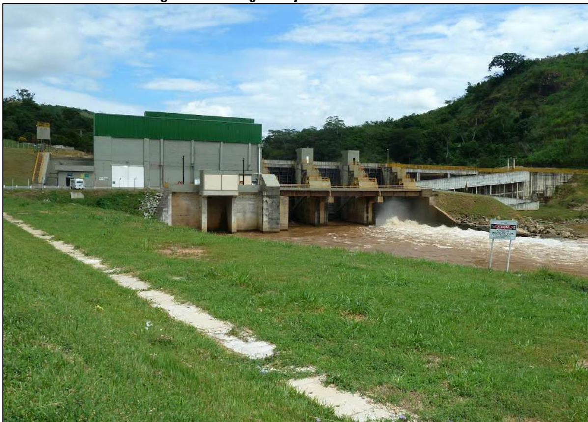
Figura 1 – Vista geral a jusante da PCH Monte Serrat
