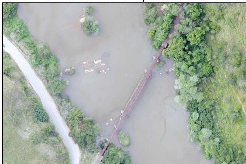
Figura 45 – Ponte 08 localizada entre os municípios de Chiador – MG e Três Rios – RJ
