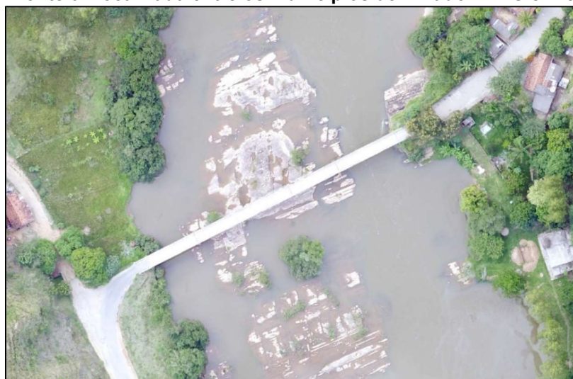
Figura 43 – Ponte 07 localizada entre os municípios de Chiador – MG e Três Rios – RJ
