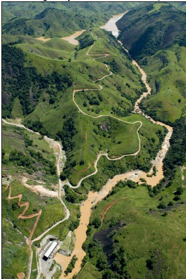
Figura 6 – Detalhe da Região a jusante da Casa de Força da PCH São Simão
