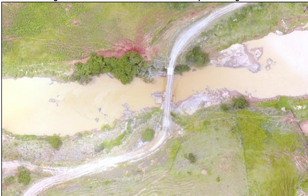
Figura 21 – Ponte 01 localizada no município de Alegre – ES
