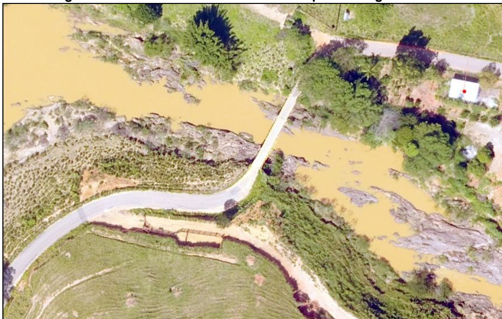
Figura 27 – Ponte 03 localizada no município de Alegre – ES
