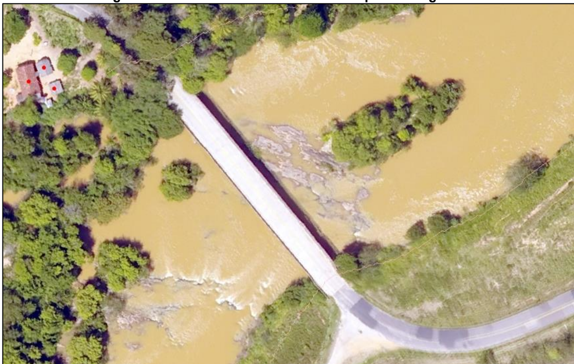
Figura 34 – Ponte 04 localizada no município de Alegre – ES
