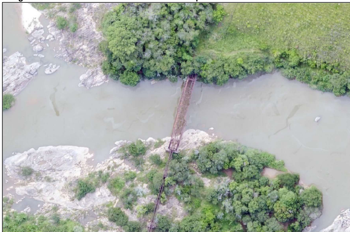
Figura 38 – Ponte 06 localizada entre os municípios de Chiador – MG e Três Rios - RJ
