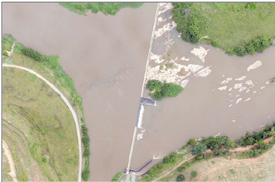
Figura 36 – Estrutura do Desvio da PCH Santa Fé, município de Comenador Levy Gasparian - RJ
