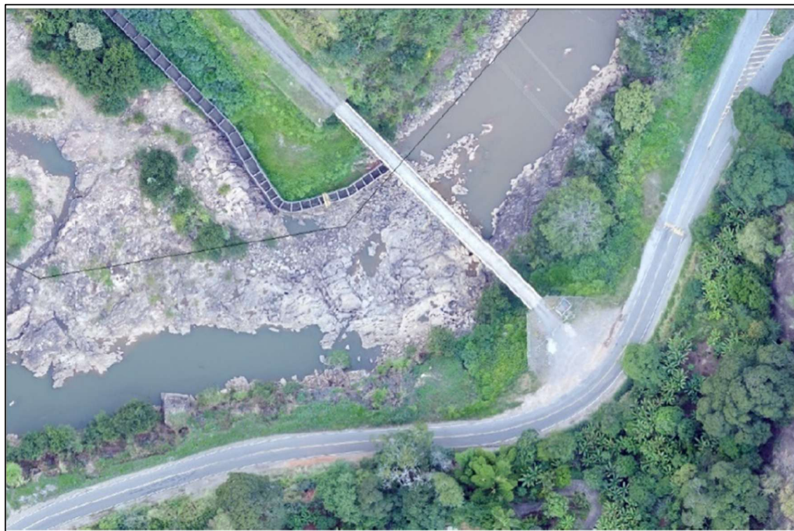
Figura 18 – Ponte 01 localizada entre os municípios de C. Levy Gasparian – RJ e Simão Pereira - MG
