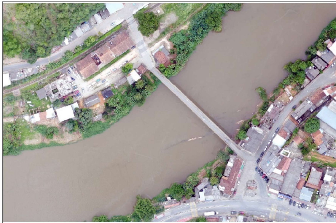
Figura 24 – Ponte 04 localizada entre os municípios de Comendador Levy Gasparian – RJ e Santana do Deserto - MG
