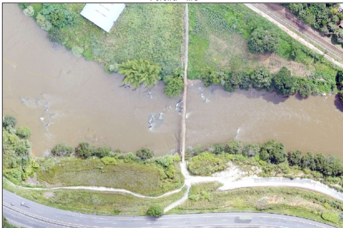
Figura 22 – Ponte 03 localizada entre os municípios de C. Levy Gasparian – RJ e Simão Pereira – MG
