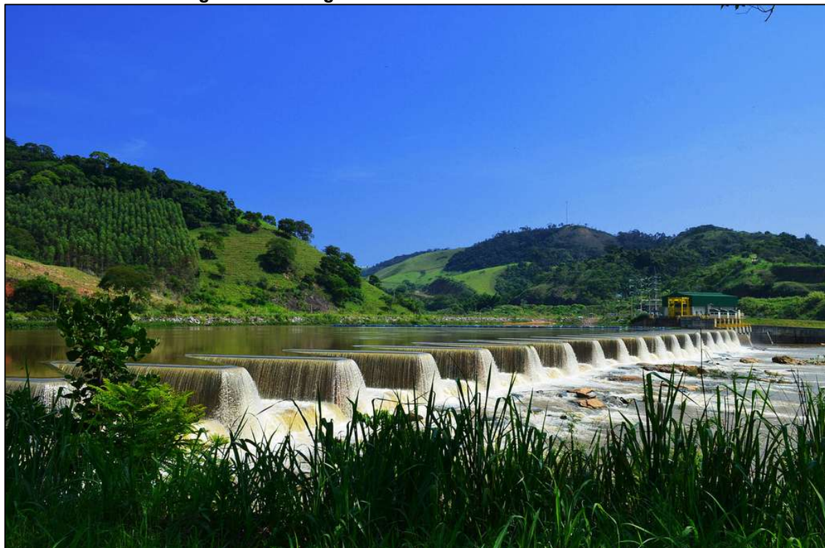
Figura 2 – Vista geral do vertedouro da PCH Bonfante
