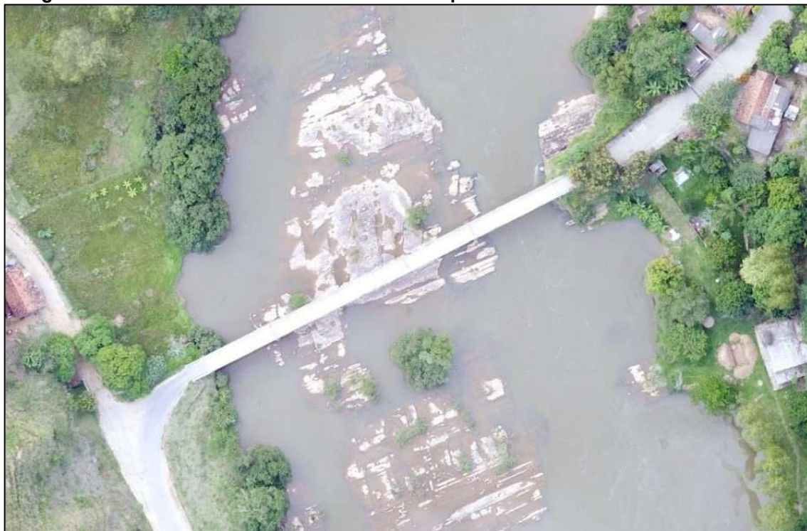
Figura 41 – Ponte 07 localizada entre os municípios de Chiador - MG e Três Rios – RJ
