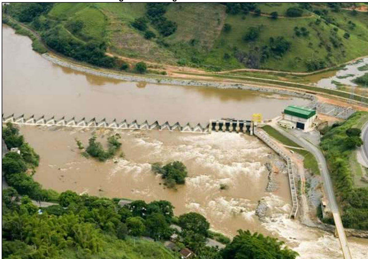
Figura 1– Vista geral da PCH Bonfante
