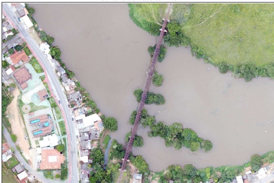
Figura 26 – Ponte 05 localizada entre os municípios de Comendador Levy Gasparian – RJ e Santana do Deserto - MG
