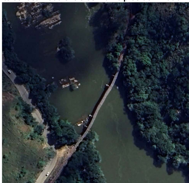
Figura 28 – Ponte 03 localizada entre os municípios de Chiador - MG e Três Rios – RJ
