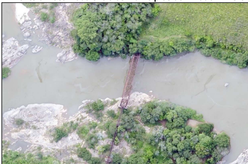
Figura 24 – Ponte 01 localizada entre os municípios de Chiador - MG e Três Rios - RJ
