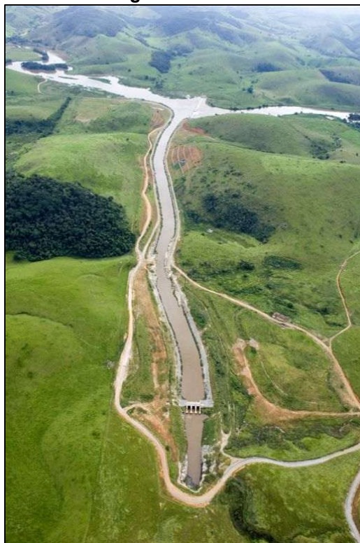
Figura 7 – Detalhe do emboque do túnel, estrutura de controle, canal de adução e barragem vertical
