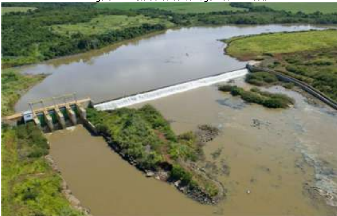
Figura 1 – Vista aérea da barragem da PCH Jataí
