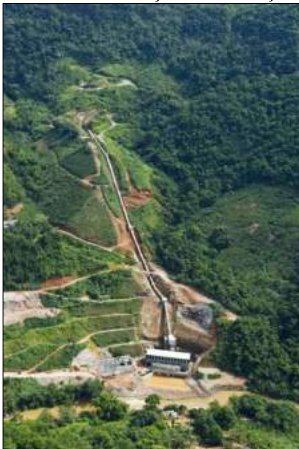
Figura 7 - Detalhe do Túnel de Adução e Casa de Força da PCH São Pedro
