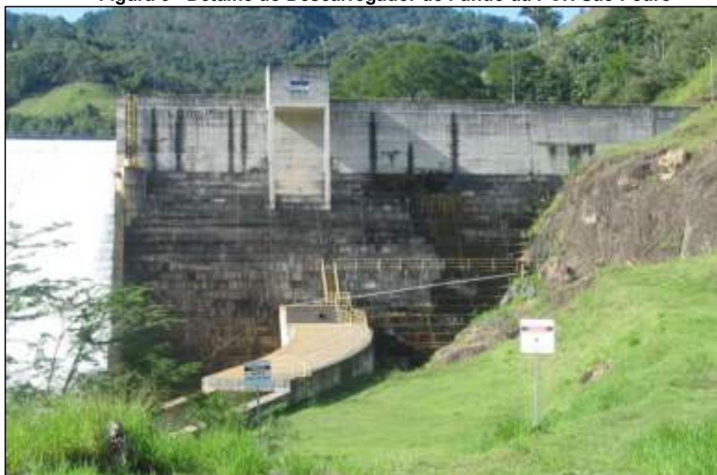
Figura 6 - Detalhe do Descarregador de Fundo da PCH São Pedro
