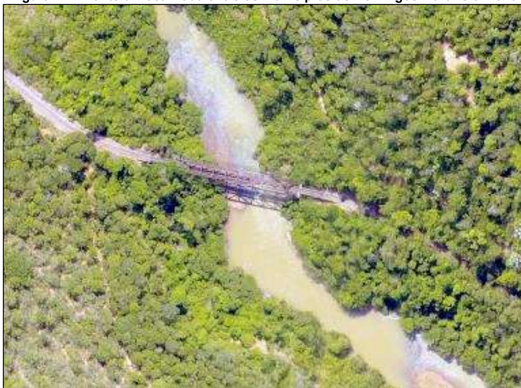
Figura 47 – Ponte 07 localizada entre os municípios de Domingos Martins e Viana
