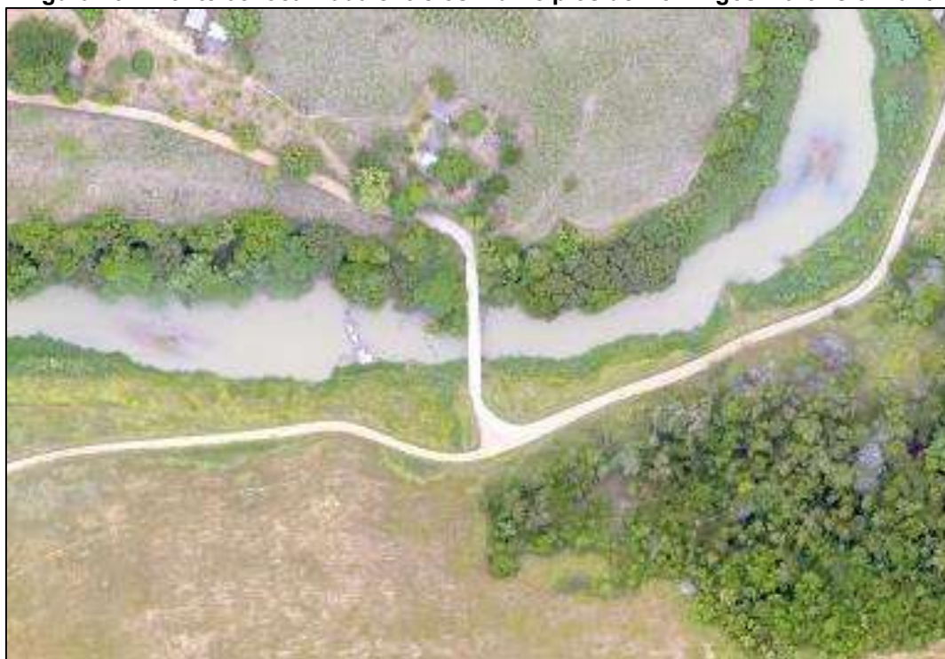
Figura 49 – Ponte 08 localizada entre os municípios de Domingos Martins e Viana
