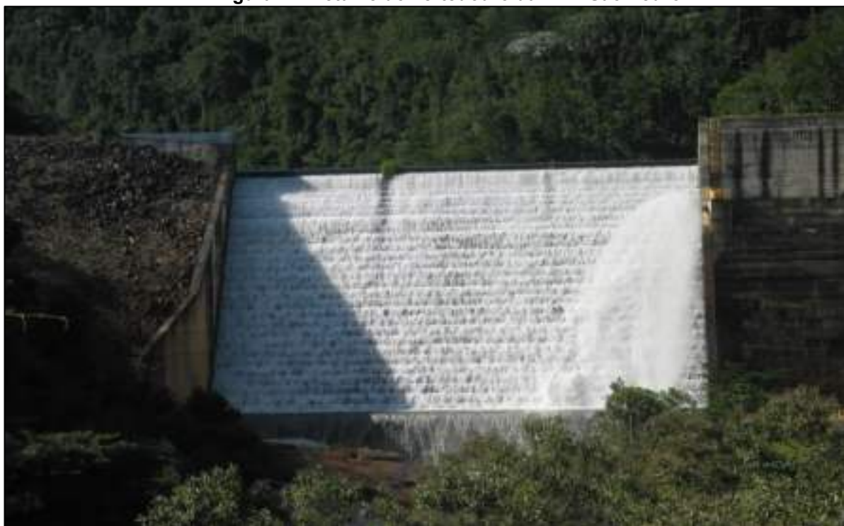
Figura 2 – Detalhe do vertedouro da PCH São Pedro
