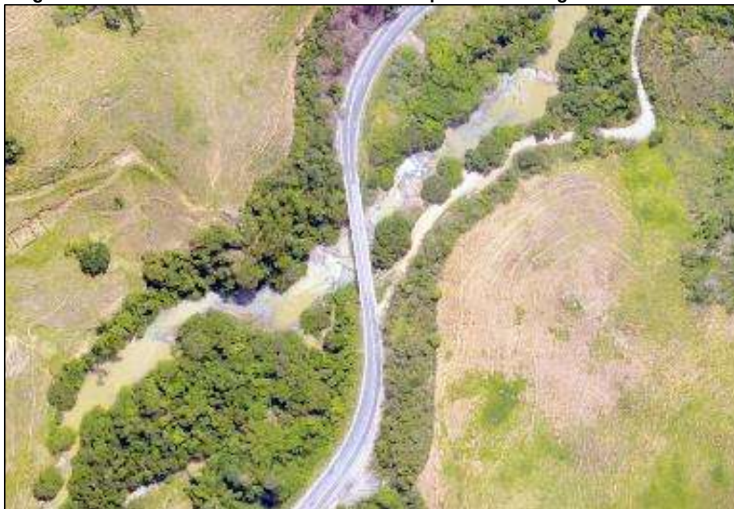
Figura 45 – Ponte 06 localizada entre os municípios de Domingos Martins e Viana
