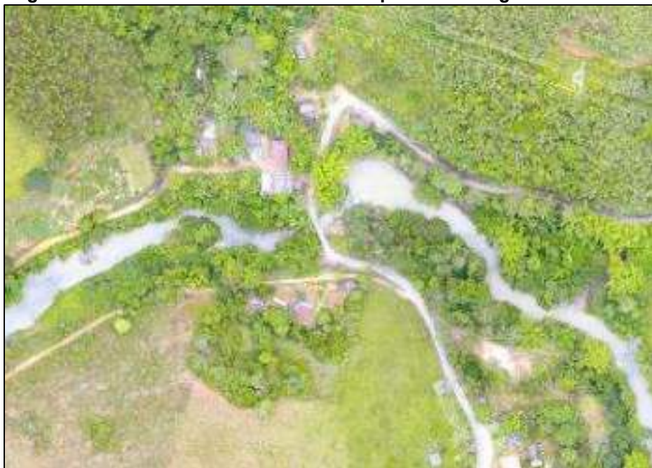
Figura 41 – Ponte 04 localizada no município de Domingos Martins – ES
