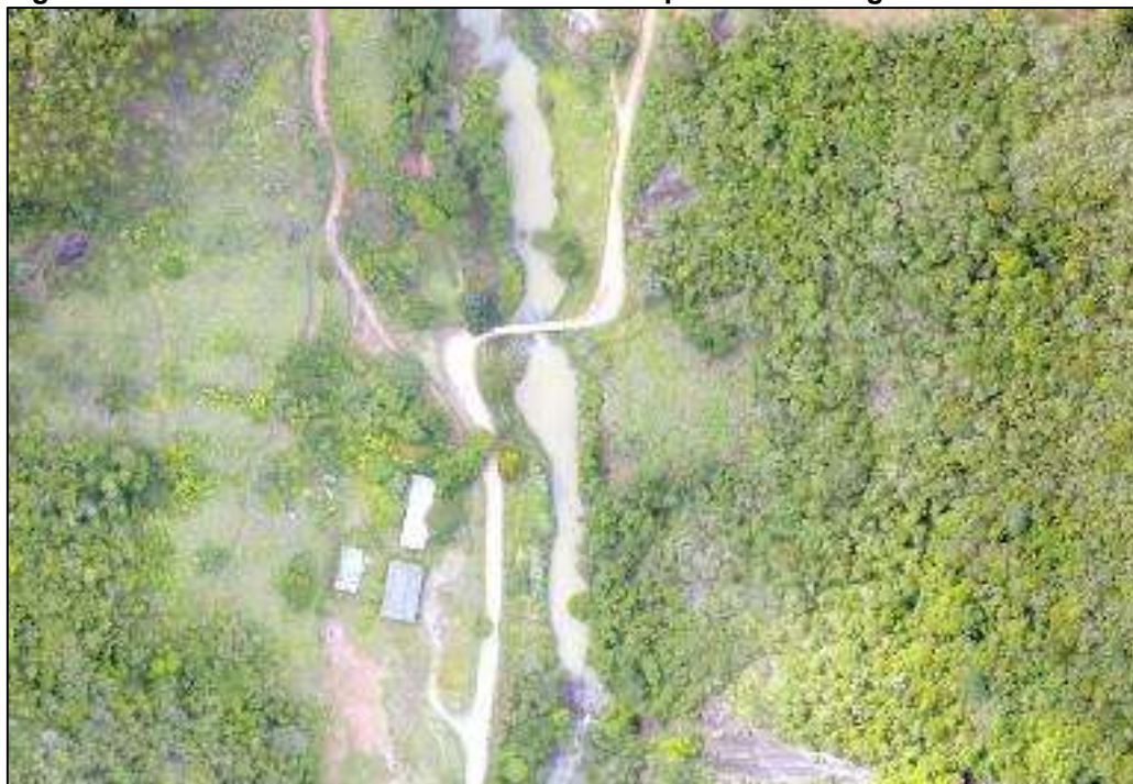
Figura 43 – Ponte 05 localizada entre os municípios de Domingos Martins e Viana
