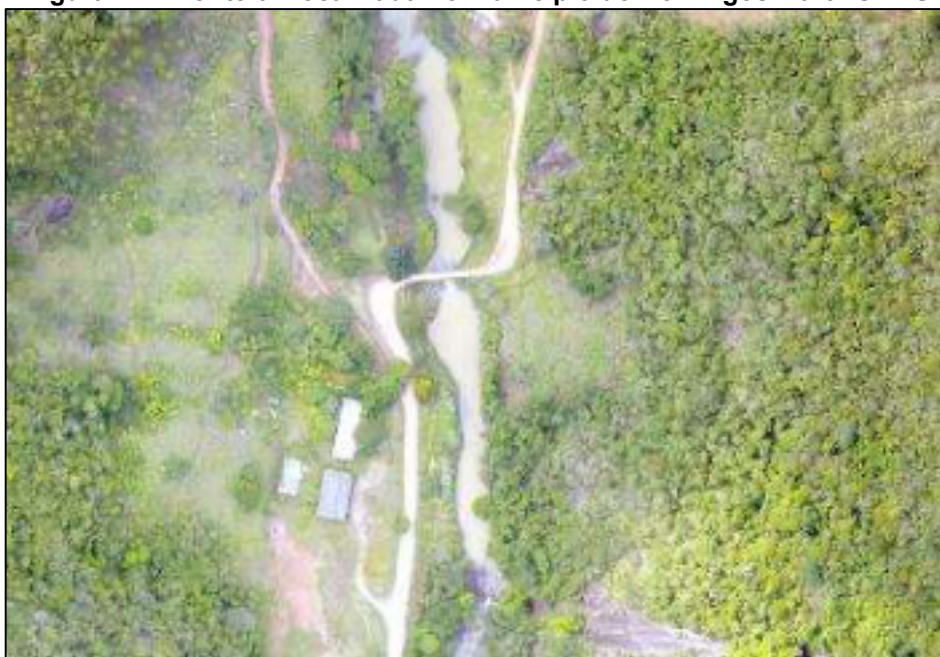
Figura 21 – Ponte 01 localizada no município de Domingos Martins - ES
