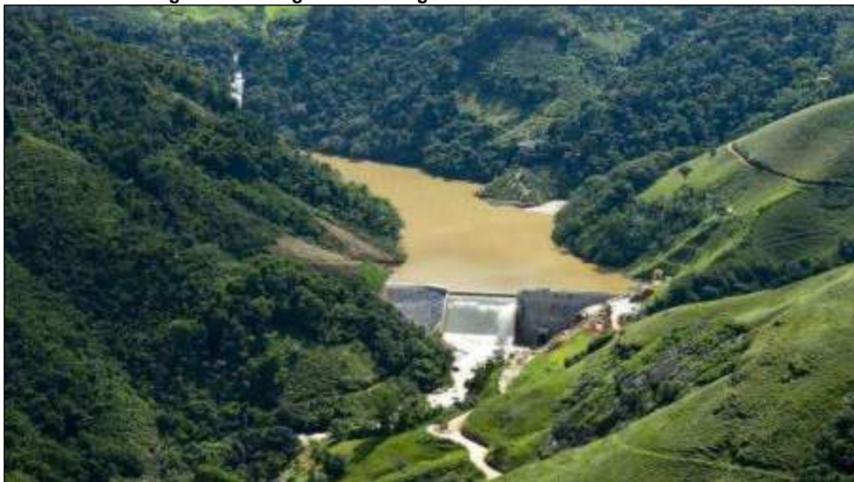
Figura 1– Vista geral da barragem e vertedouro da PCH São Pedro
