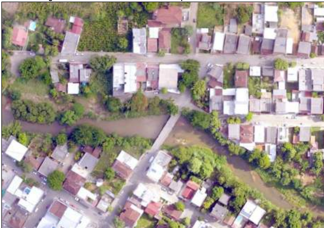
Figura 26 – Ponte 04 localizada no município de Alfredo Chaves – ES
