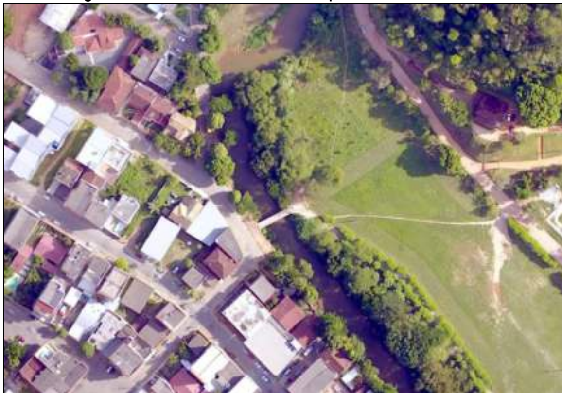
Figura 28 – Ponte 05 localizada no município de Alfredo Chaves – ES
