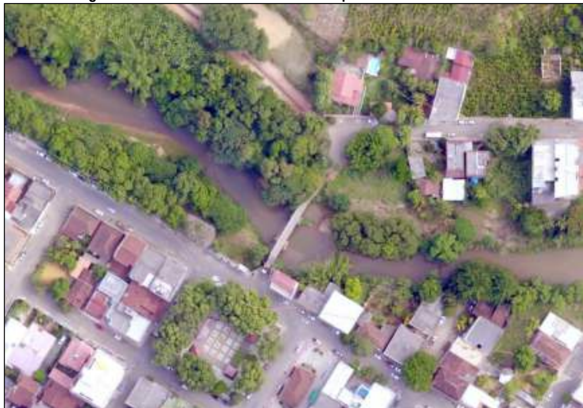
Figura 24 – Ponte 03 localizada no município de Alfredo Chaves – ES
