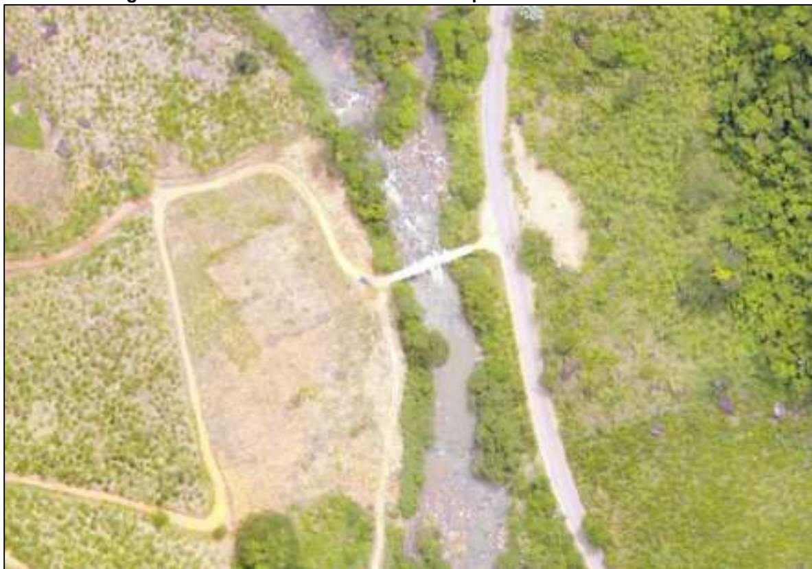
Figura 20 – Ponte 01 localizada no município de Alfredo Chaves – ES
