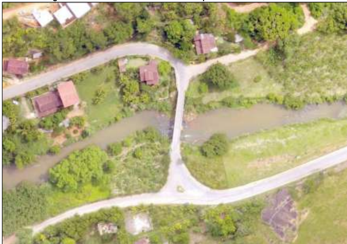
Figura 22 – Ponte 02 localizada no município de Alfredo Chaves – ES
