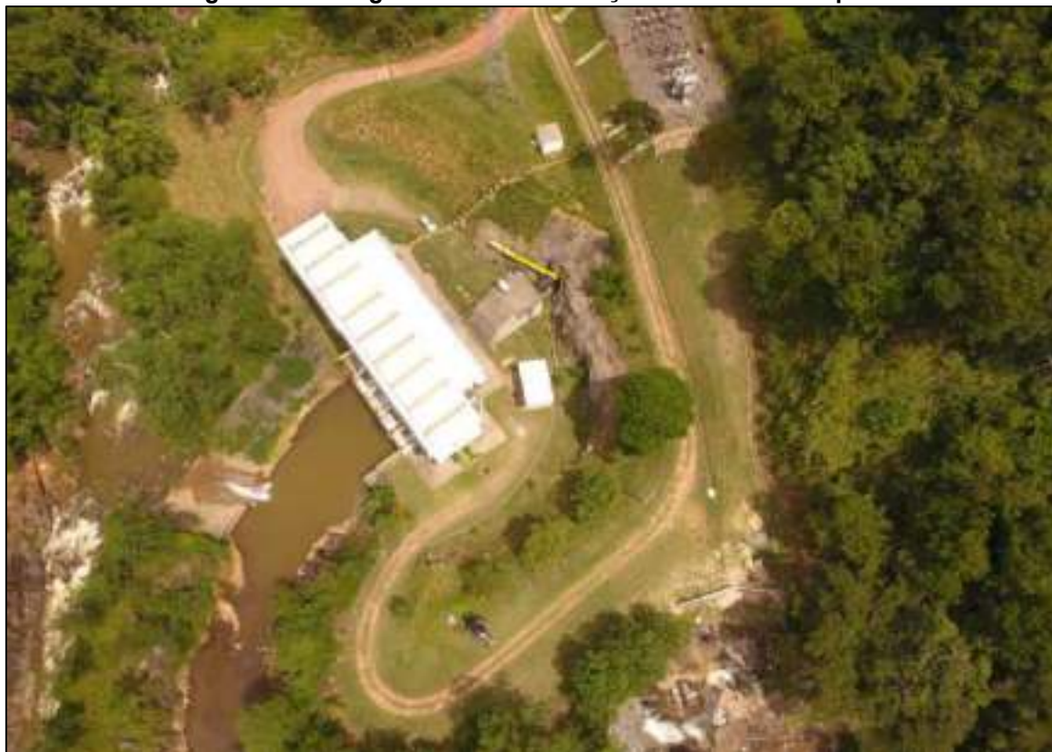
Figura 2 – Vista geral da Casa de Força da PCH São Joaquim
