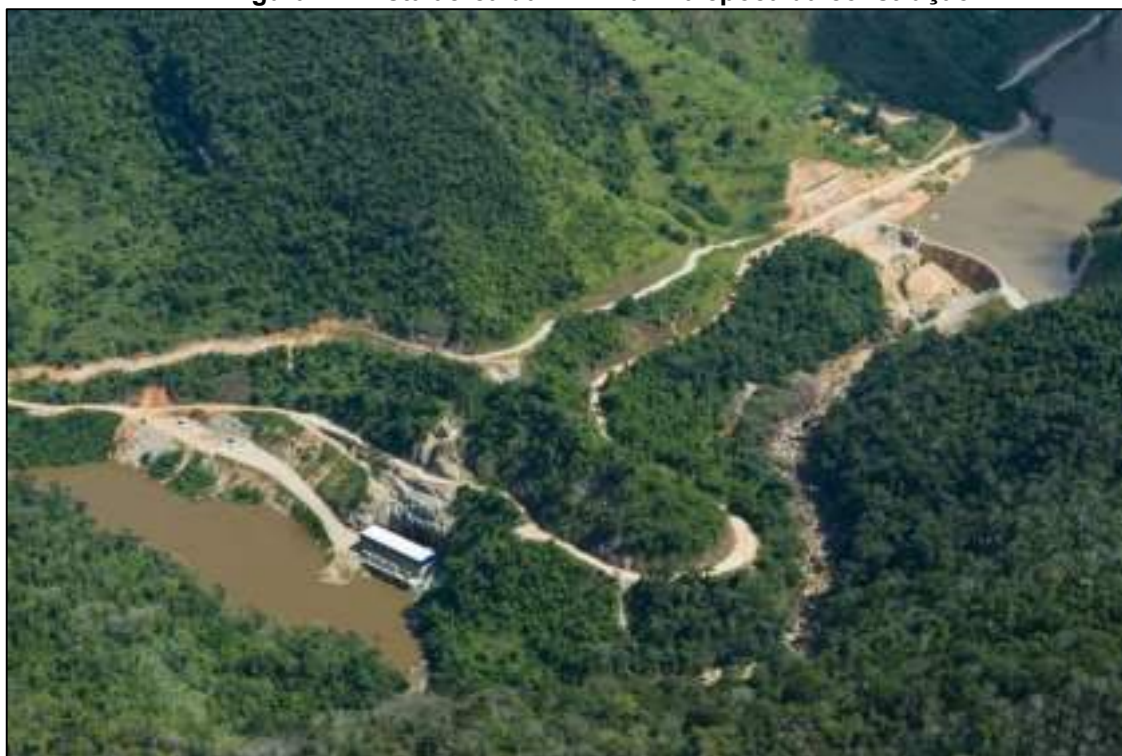
Figura 1 – Vista aérea da PCH Funil à época da construção
