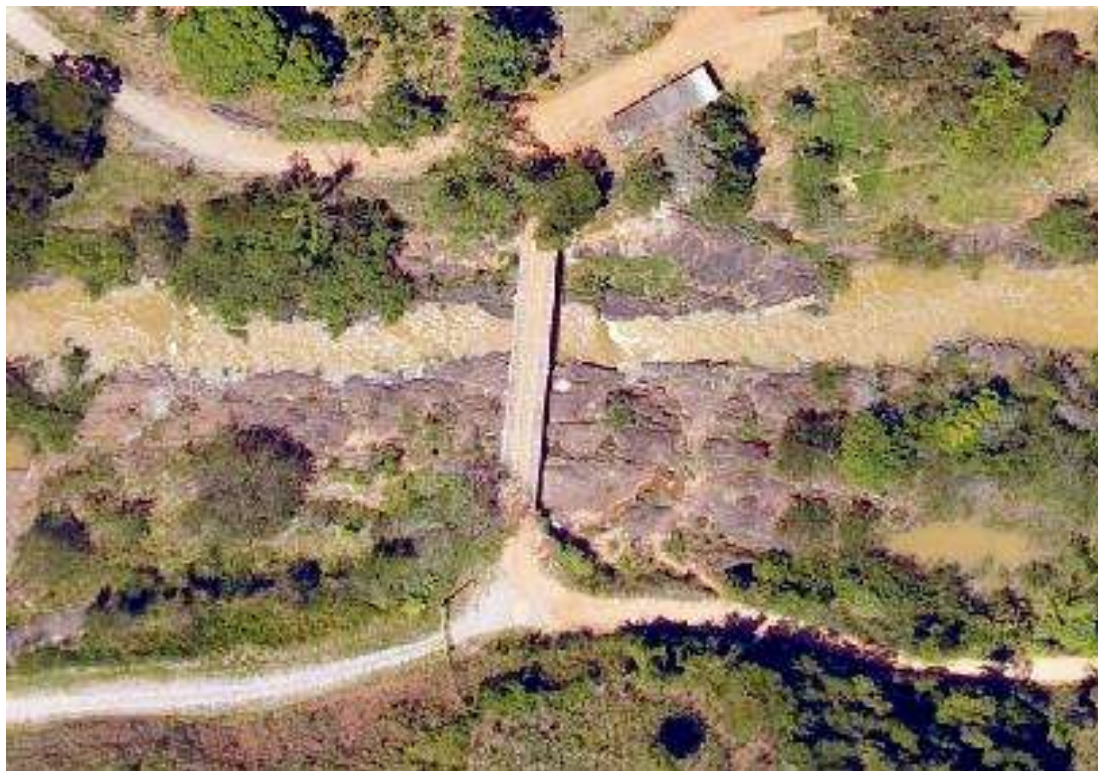
Figura 20 – Ponte 01 localizada entre os municípios de São José do Calçado – ES e Bom Jesus do Itabapoana - RJ
