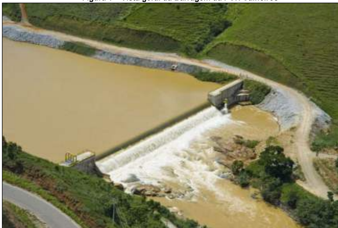
Figura 1 – Vista geral da Barragem da PCH Calheiros
