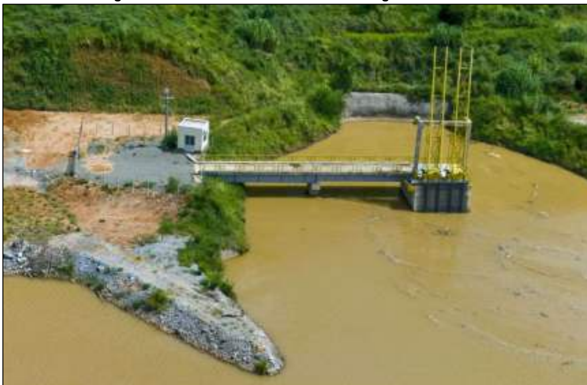
Figura 2 – Vista da estrutura da Tomada D'água da PCH Calheiros
