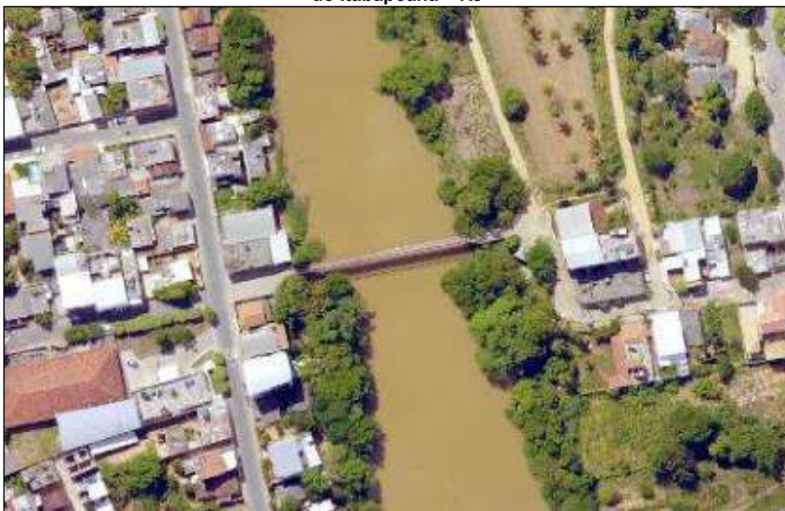
Figura 32 – Ponte 04 localizada entre os municípios de Bom Jesus do Norte – ES e Bom Jesus do Itabapoana – RJ
