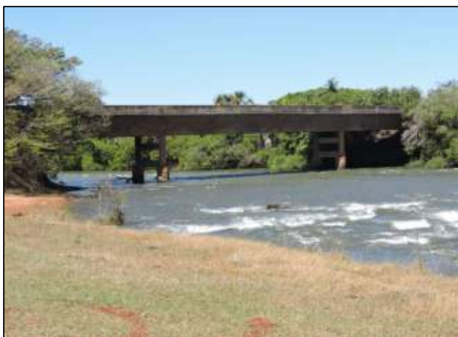
Figura 18– Ponte localizada no município de Aporé – GO
