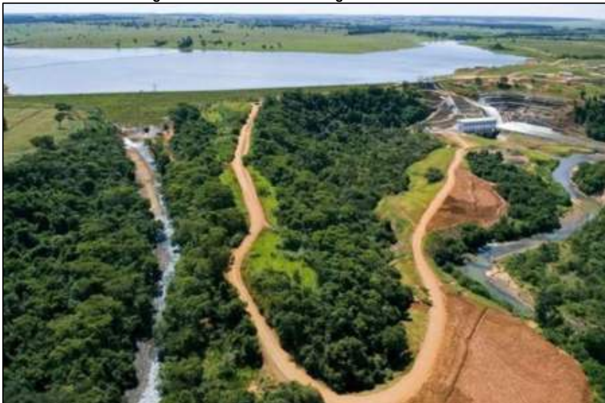
Figura 1 – Vista aérea da barragem da PCH Retiro Velho
