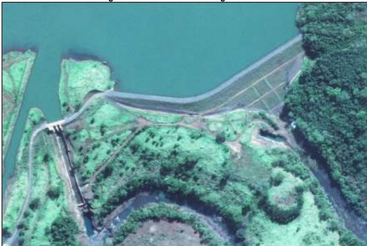
Figura 2 – Vista aérea da barragem da PCH Irara
