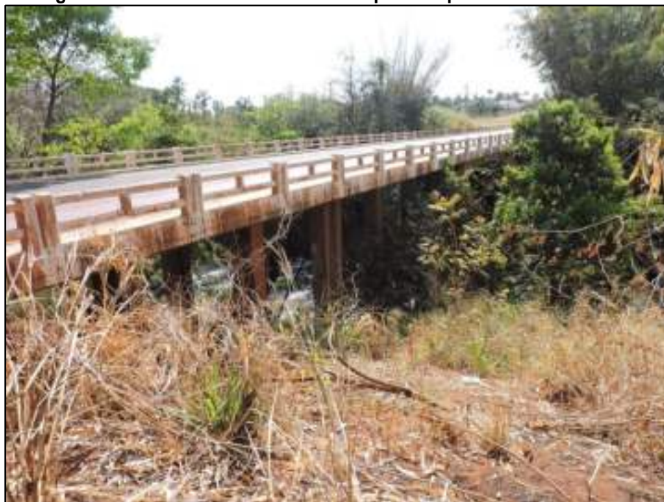
Figura 31– Ponte localizada no município de Aparecida do Rio Doce
