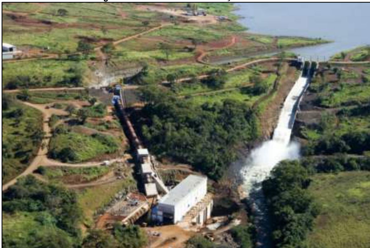
Figura 1 – Vista aérea das instalações da PCH Irara
