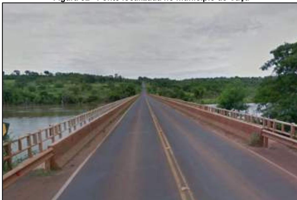
Figura 32– Ponte localizada no município de Caçu
