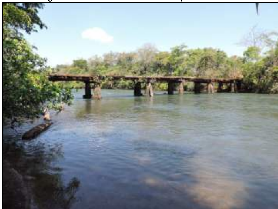
Figura 30– Ponte localizada no município de Rio Verde
