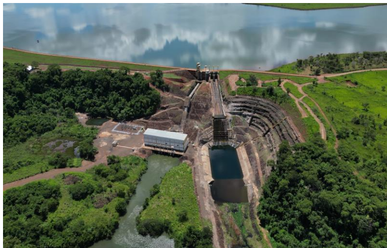
Vista aérea das instalações da PCH Retiro Velho
